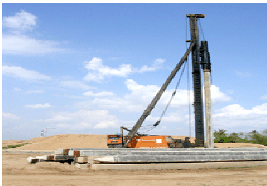
Gói thầu số 3 (đường dẫn cầu Cần Thơ, phía Cần Thơ) đang được khẩn trương thi công. Ảnh: THIÊN KHIÊM
